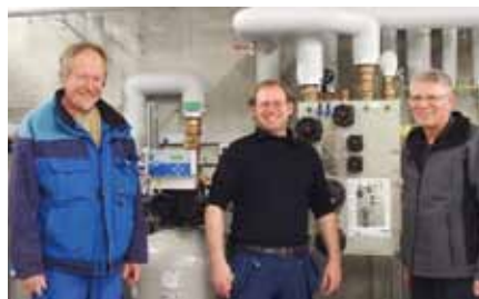
v.l. Werner Bolliger, Hauswart der Schulhäuser Späri und Oberdorf; Beat Studer, Brunnenmeister, und Vlado Simov, Hauswart der Raiffeisen-Arena, besprechen die komplexe Technik im «Untergrund» der Raiffeisen-Arena.
