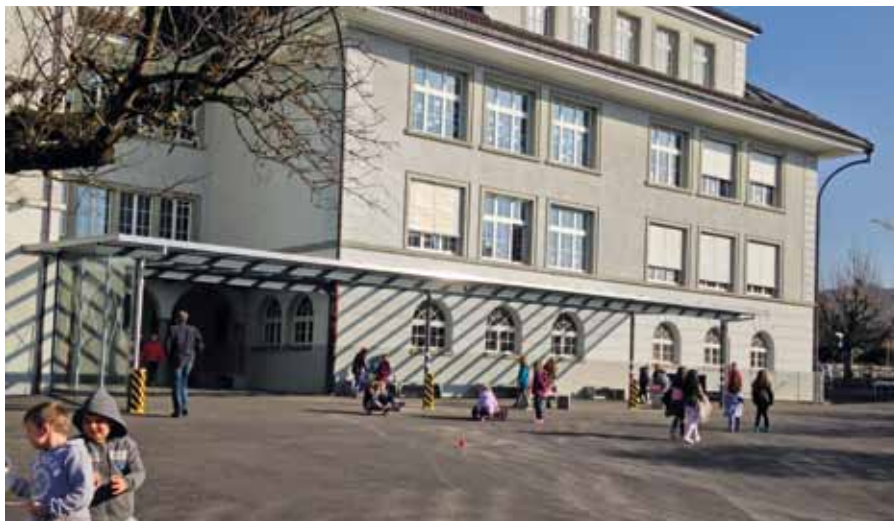
Dank des neuen Vordachs können die Kinder des Schulhauses Oberdorf ihre Pause auch bei Regen im Trockenen an der frischen Luft verbringen.
