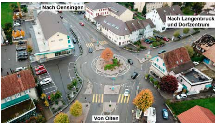
Der Kreisels Kreuzplatz muss saniert werden.
