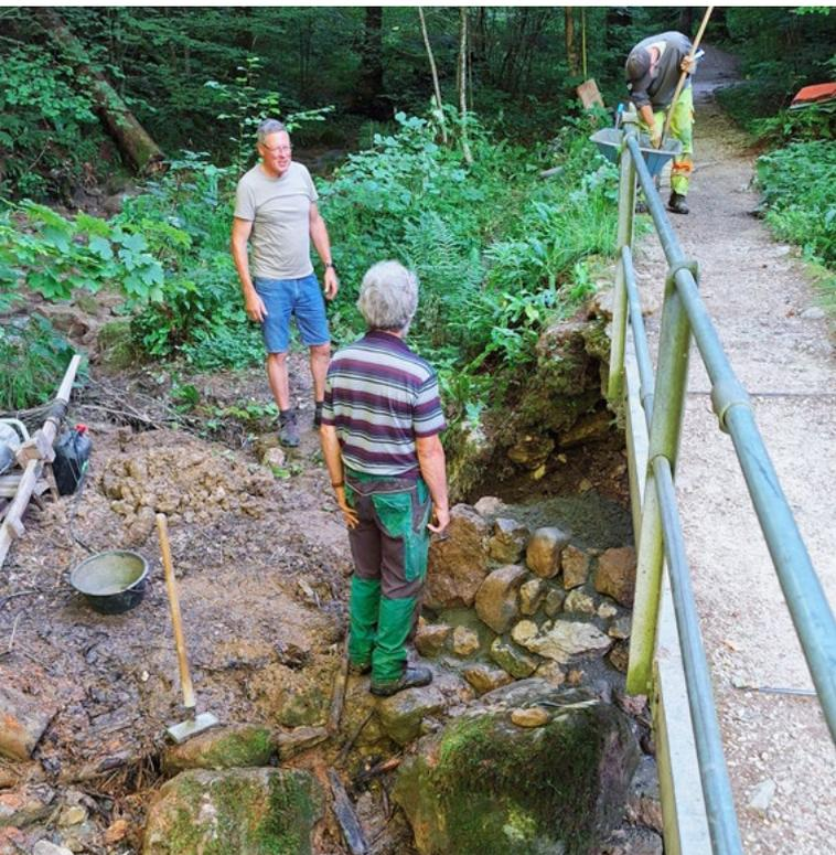
*Ein Brückenlager muss neu aufgemauert werden.*
