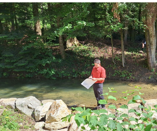
Jürg Hunziker auf dem neu erstellten Damm, welcher gezielt Wasser links Richtung Auenwald abzweigt.
