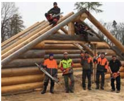
Blockhausbauerkurs in Hägendorf 2017. Ein Gartenhaus entsteht.
