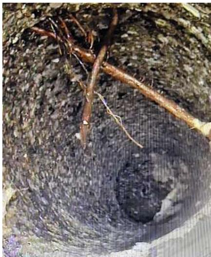
*Abwasserrohr mit Wurzelbewuchs*
